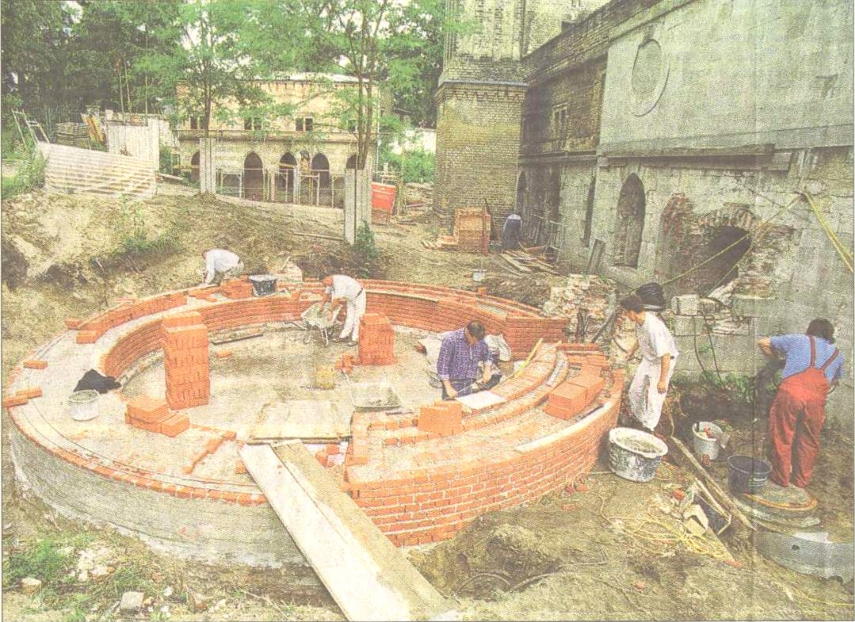
Eiskeller Jahrzehntlang war der Eiskeller der Meierei im Neuen Garten eingestürzt und verschüttet. Und genau darüber führte der Betonweg für die Streifenfahrzeuge der DDR-Grenzer. Zwei Berliner lassen das Objekt derzeit zu einer Gasthausbrauerei umbauen und dabei auch den vergessenen Keller wieder errichten. Hier stehen künftig die Gärbottiche für bis zu 24 Sorten Meierei-Bier. Im Wasch- und Stallhaus geradezu kommen Versorgungsaggregate und Lagertanks unter. Das eigentliche Gasthaus mit den Braukesseln befindet sich im Haupthaus rechts und hat direkten Zugang zur Havel. FOTO: MAZ/PLAGEMANN
