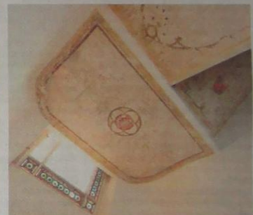
Im Treppenhaus wurden Deckenmalereien mit einem Wappen freigelegt. Sie werden restauriert.
