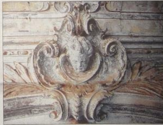
Ornamente an der Kirchendecke und der Altarwand: Befestigt wurden diese mit Schrauben. Sichtbar für alle werden die erst nach dem Entfernen der eingezogenen Arbeitsdecke.
