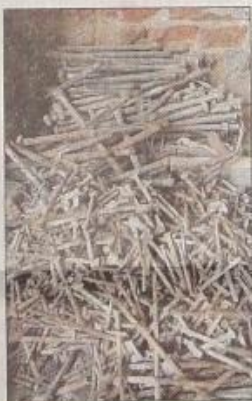
Rostige Schrauben: Hunderte entfernten die Stuckateure und ersetzten sie durch neue.
