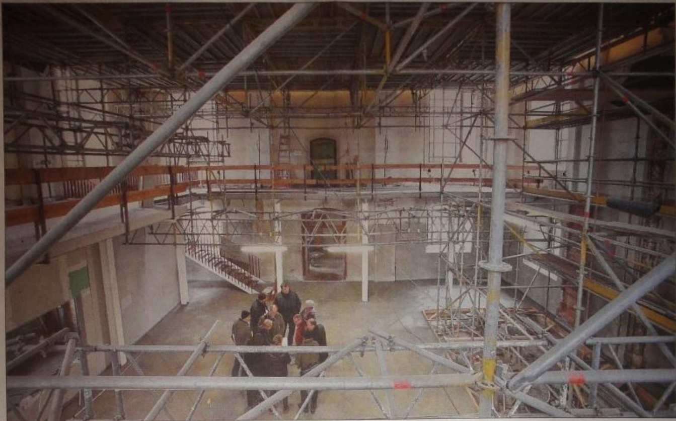
Blick von der Empore: Die Aufteilung der Schlosskirche Altlandsberg ist inzwischen deutlich erkennbar. Hinten der Eingang von der Klosterstraße, links unter der Empore die Öffnung zur Garderobe und das barrierefreie WC. Rechts wird die Bühne installiert. Mit dem Denkmalschutz wird gerade über die Bodenfliesen beraten. Fotos (3): MOZ/Gerd Markert
