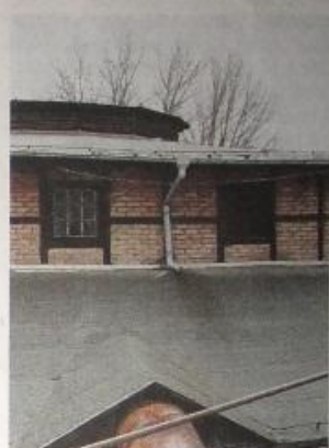
Die Schürebene des Ringofens am Glindower See: Hinter der Hülle erfolgt für den Brand die Kohlebeheizung durch Schuttlöcher.
