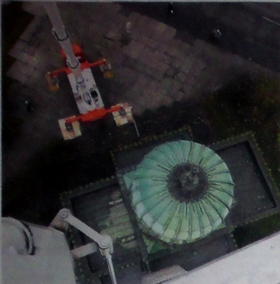
Schwindelerregend ist der Blick von der Arbeitsbühne hinab zur Straße.
