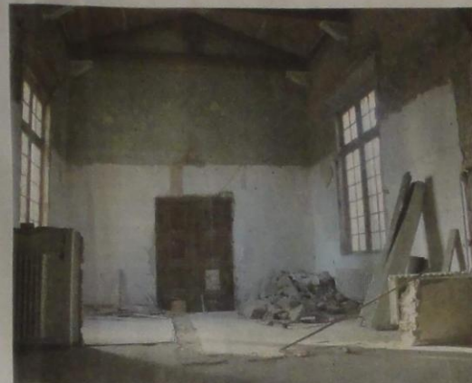
Da waren der Bürofußboden und Reste der Zwischenwände noch drin: Man sieht die teils verschüttete Tür und wo an den Fensterkreuzen die Zwischendecke hing.
