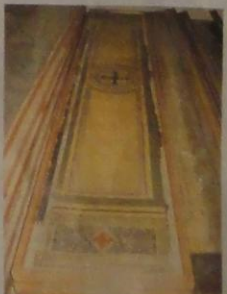
Die Kassettendecke war nicht aus Holz, sondern aus bemalten Stoffbahnen. FOTO: REDLICH ARCHITECTEN
