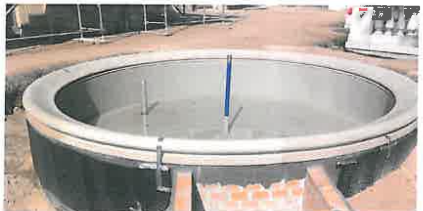
Abb. 2 Instandgesetzter Brunnen mit innerer Abdichtung und neuem Profilkranz, Potsdam, Große Weinmeisterstraße, Villa Henckel, Brunnen auf der rückwärtigen Terrasse des Hauses
