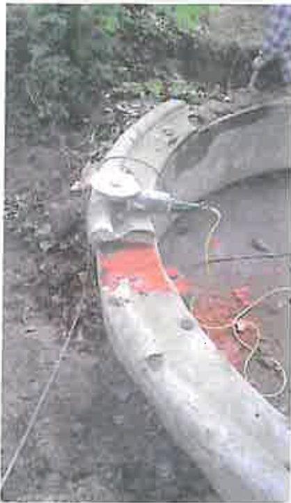
Abb. 3 Zerstörter Profilkranz
