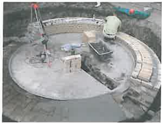
Abb. 5 Gemauerte Rekonstruktion eines historischen Brunnens
