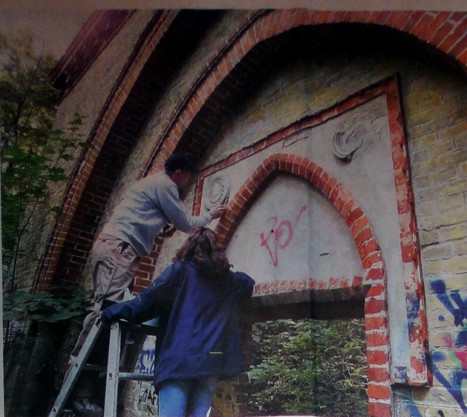
Eine kaputte Rosette des Brunnentores wird ersetzt. Die Form dazu gab es noch im Archiv von Roland Schulze.
