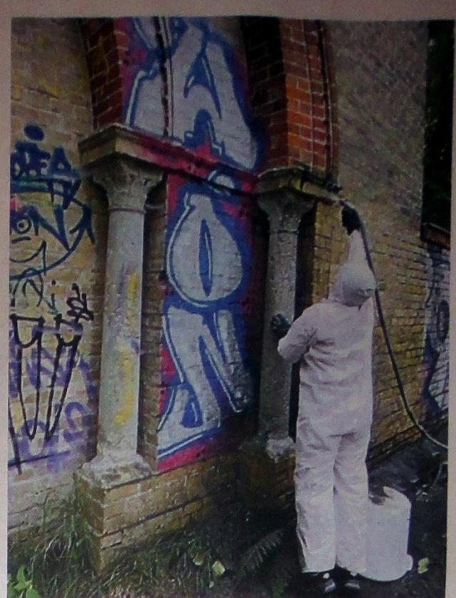
Mühsam werden Graffiti-schichten vom Mauerwerk gelöst. FOTOS: R.S.
